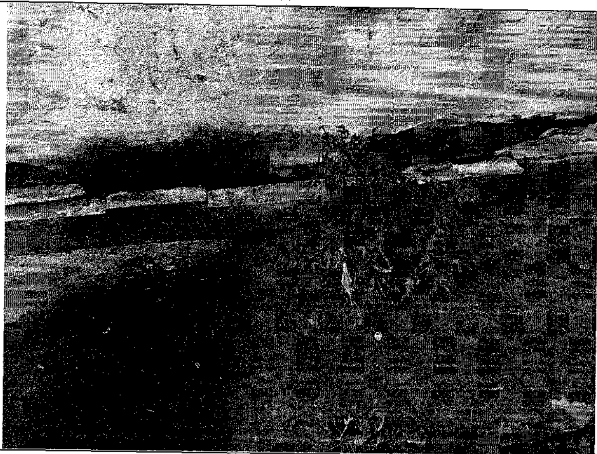
Фото 5. Дворовой фасад. Трещины между отмосткой и цокольной частью стены здания.
