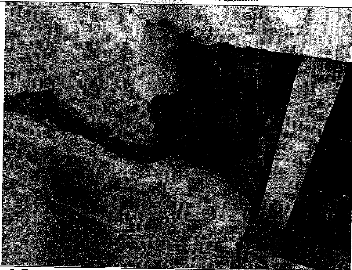
Фото 5. Дворовой фасад. Трещины между отмосткой и цокольной частью стены здания.
